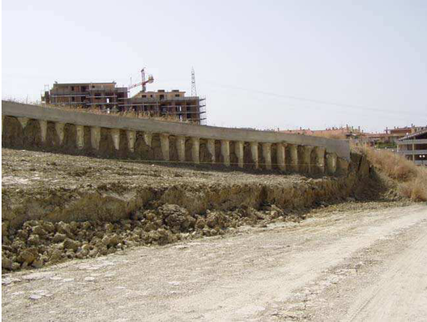
Foto 5.7 – PdL Giada. Paratia di protezione dell'area.
