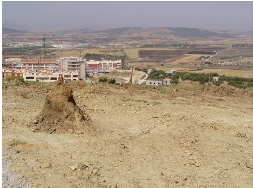
Foto 5.8 – PdL Giada. Lavori di sbancamento effettuati..
