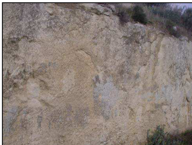
Foto 4.5. – Fronte di scavo lungo la S.S. n. 7.
