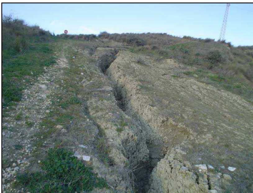
Foto 5.6 – Solco erosivo di neoformazione in materiali limoso-argillosi, lungo un tratturo che segue la linea di massima pendenza. Il dilavamento concentrato è stato favorito dalla mancanza di vegetazione.
